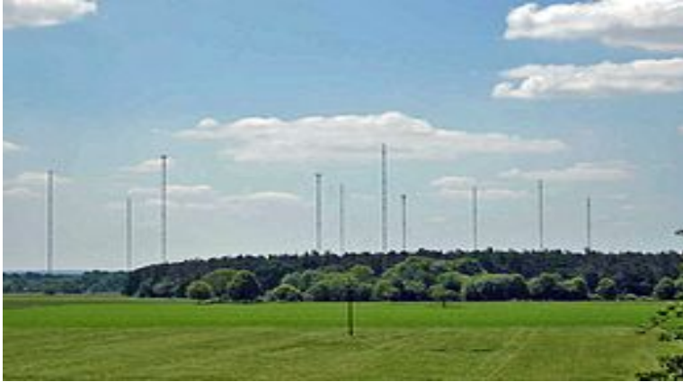
Zendmasten bij Mainflingen(D). Periodiek wordt hier vandaan een 'tijds telegram' in de ether uitgezonden op een frequentie van 77 kHz.
